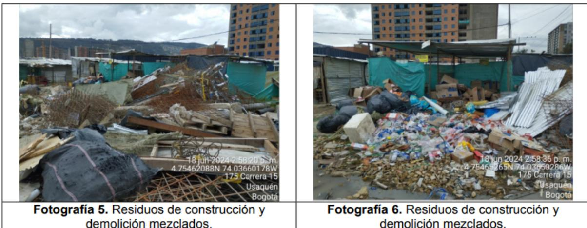
*Como se observa en el registro fotográfico, no existe una separación en la fuente y no se instalaron acopios temporales para el almacenamiento de los residuos de construcción y demolición. Dentro de los residuos mezclados la gran mayoría son susceptibles de aprovechamiento, tales como, metales, plásticos, madera, cartón-yeso (drywall), papel, entre otros.*
